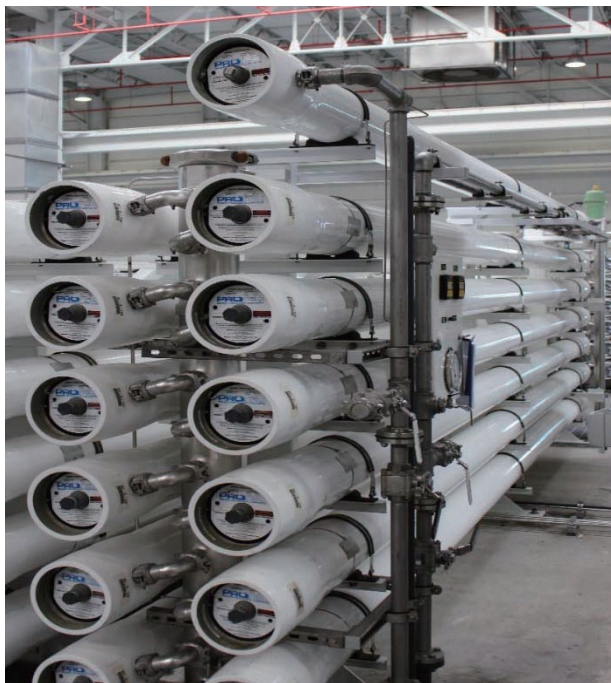
图 6. 安装在 GWRS5mgd 反渗透单元顶部的测试容器
