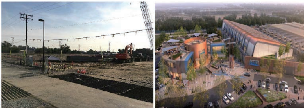
图 3.WRD 地下水可靠性改善项目
